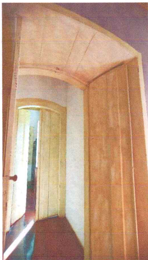
Figura 34: Detalhe das portas no piso superior
