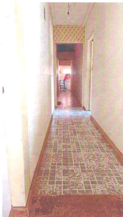
Figura 27: Corredor de acesso à cozinha e lavanderia
