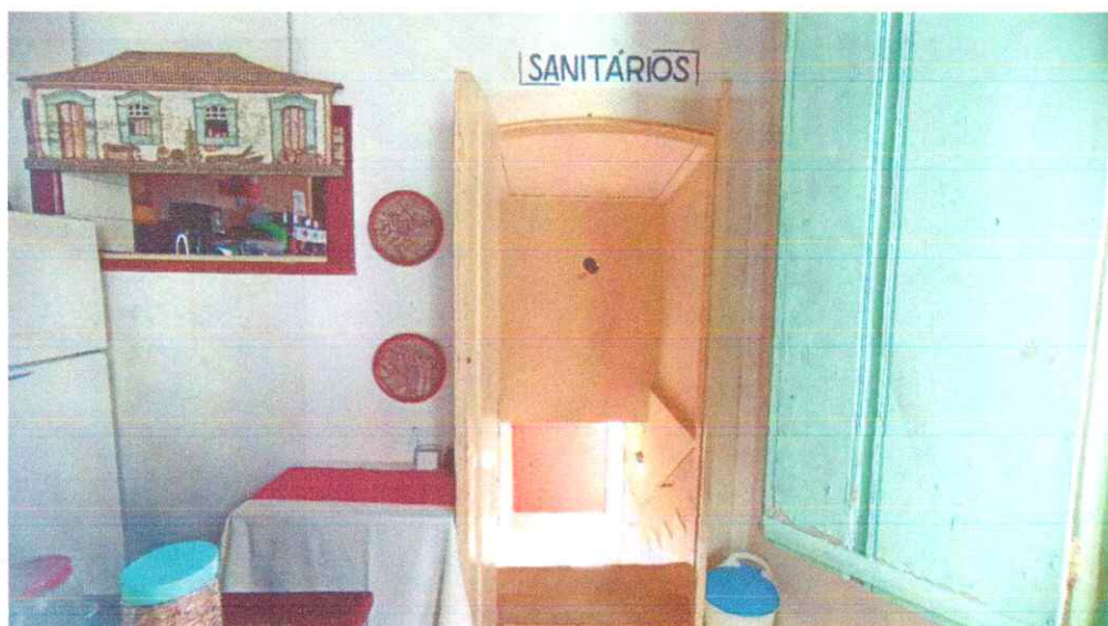
Figura 22: Entrada para os sanitários no piso inferior
