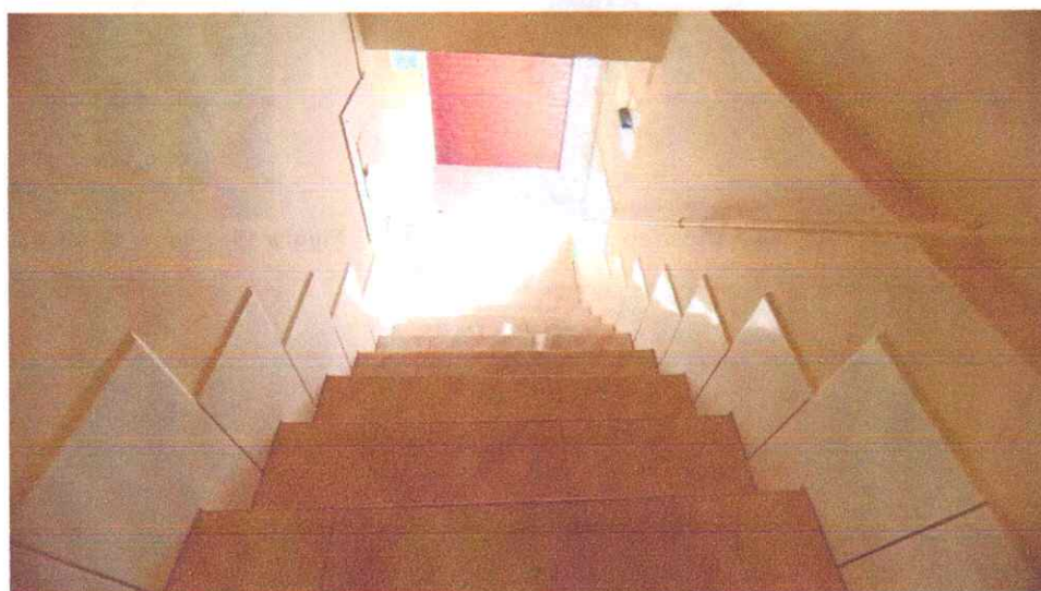
Figura 23: Escada de acesso aos sanitários no piso inferior
