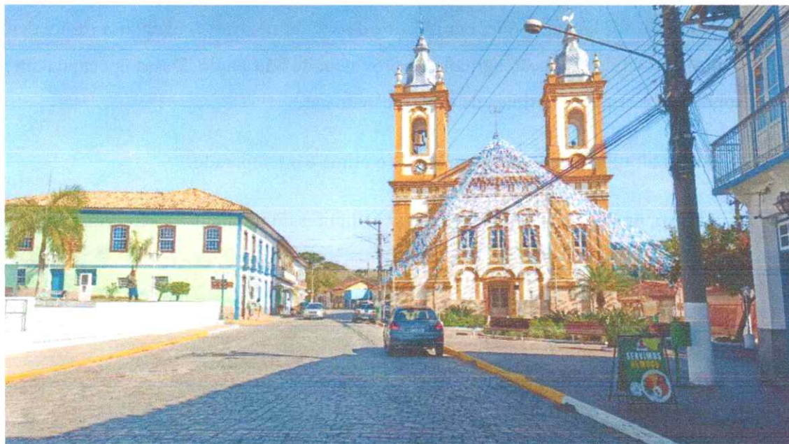
Figura 4: Rua de acesso ao imóvel. Fonte: Autor
