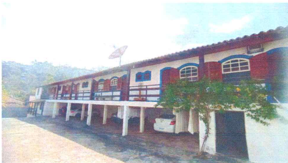
Figura 53: Vista frontal do anexo de apartamentos
