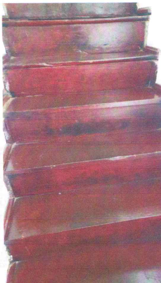
Figura 32: Detalhe da escada
