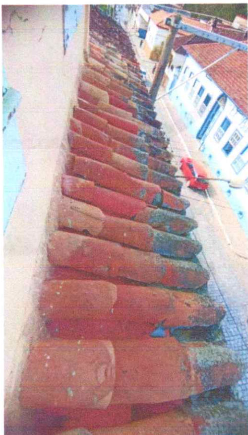
Figura 47: Telhas do beiral
