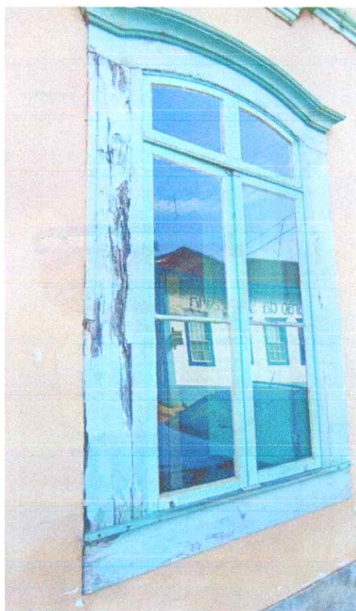
Figura 9: Janela da fachada com marcas de uso.
