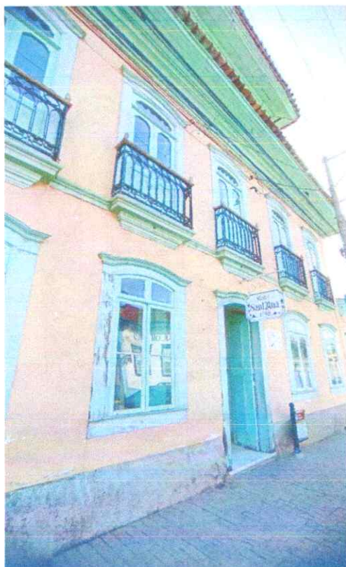
Figura 6: Vista da fachada do imóvel.
