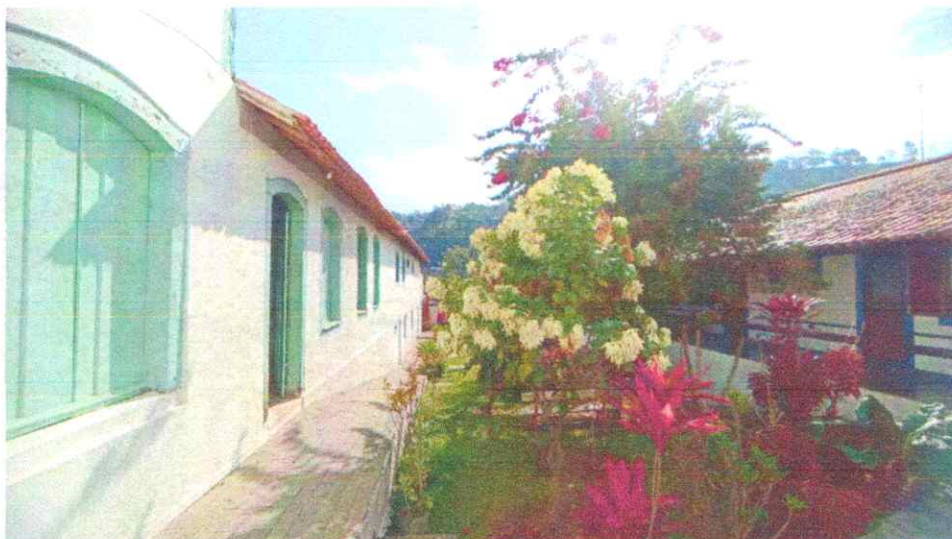
Figura 50: Vista do jardim nos fundos, com o prédio histórico do lado esquerdo e o novo anexo do lado direito
