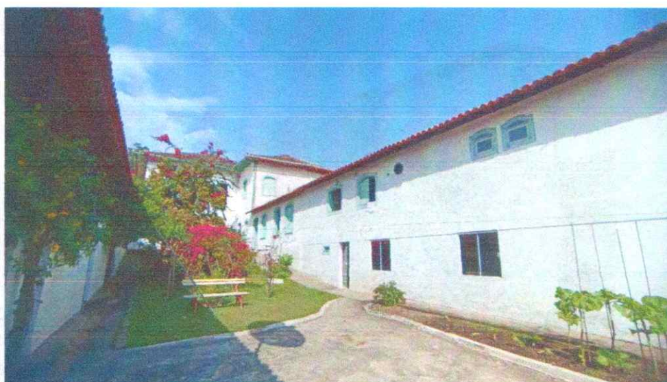
Figura 52: Vista dos fundos do jardim do hotel (prédio histórico)
