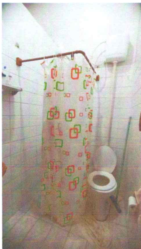
Figura 37: Banheiro de um dos quartos
