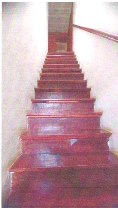
Figura 44: Escada de acesso ao 2º andar
