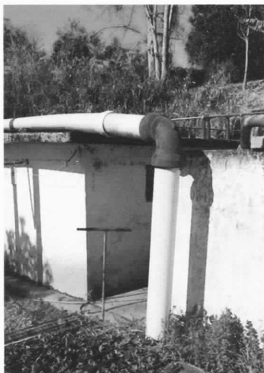
Vista da adutora no interior da ETA1, seguindo área e apoiada nas estruturas
