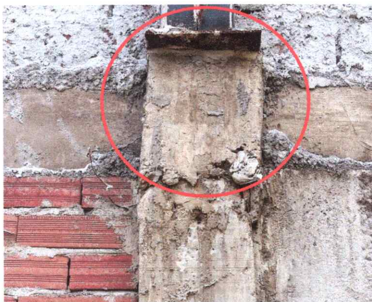
Foto 6 - Detalhe do chumbamento das colunas de AÇO sobre as colunas de CONCRETO ARMADO.
