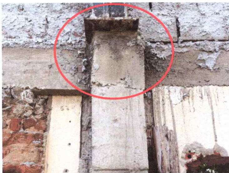
Foto 5 - Detalhe do chumbamento das colunas de AÇO sobre as colunas de CONCRETO ARMADO.
