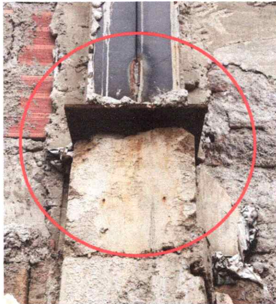
Foto 4 - Detalhe do chumbamento das colunas de AÇO sobre as colunas de CONCRETO ARMADO.
