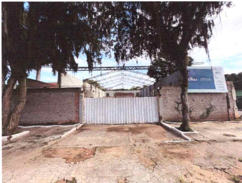
Foto 1 - Imagem Frontal do Clube Municipal de Areias.
