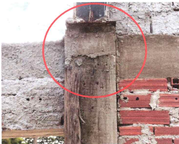
Foto 7 - Detalhe do chumbamento das colunas de AÇO sobre as colunas de CONCRETO ARMADO.
