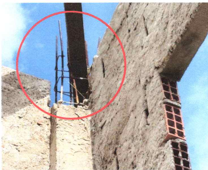
Foto 8 - Detalhe do apoio das vigas de AÇO sobre as colunas CONCRETO ARMADO.
