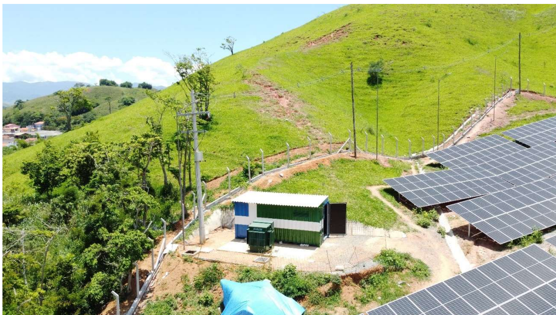
Figura 6 - Rede Particular Compacta e local do transformador Pedestal 500 kVA
