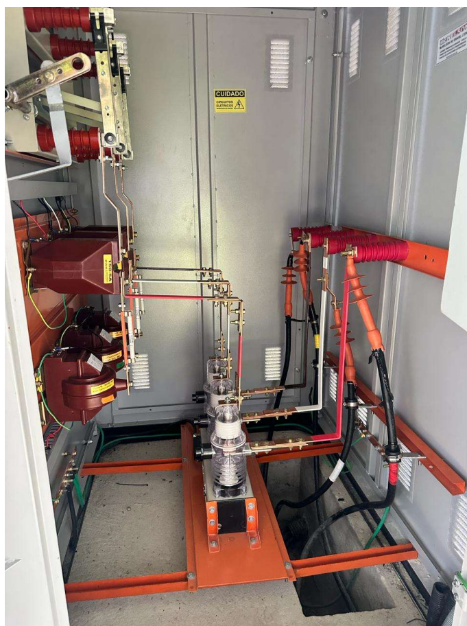
Figura 4 - Seção Proteção - Cabine Interna
