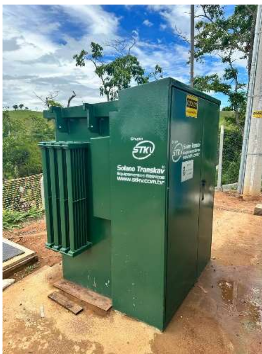
Figura 7 - Transformador Pedestal 500 kVA
