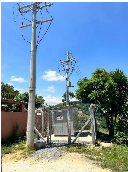
Figura 3 - Cabine Proteção e Medição
