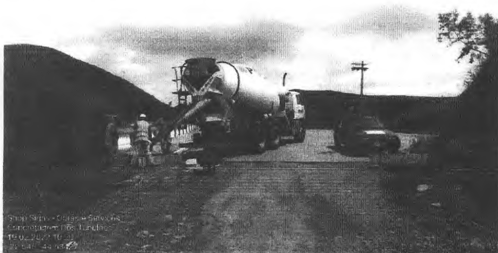
CONCRETAGENS DO TUBULÃO E BASE PARA ANCORAGEM DO PORTAL
