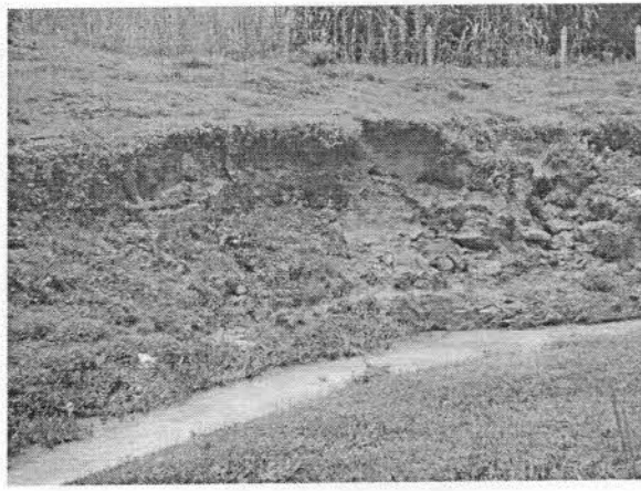
FOTO 26. Detalhe do talude de margem que apresenta sinais de solapamento. Notar volume de água nesse trecho.
