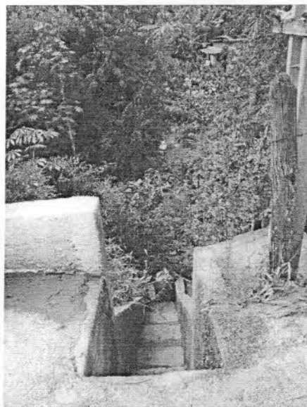
FOTO 22. Detalhe do sistema de condução das águas de chuva provindas da rodovia Areias-Queluz.
